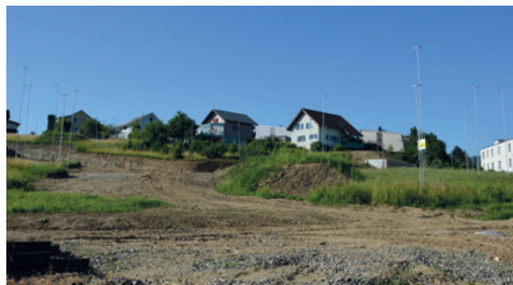
Vier Einfamilien- und fünf Mehrfamilienhäuser werden gebaut.
