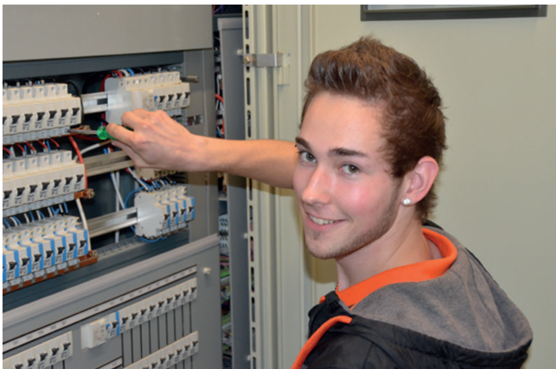
Simon Zemp, angehender Elektroinstallateur, beim Verdrahten einer Elektroverteilung am Tableau.
