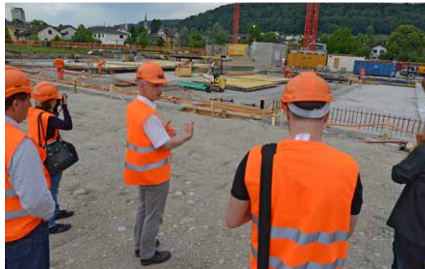
Markus Keller (Mitte) erklärt den aktuellen Stand der Bauarbeiten.
