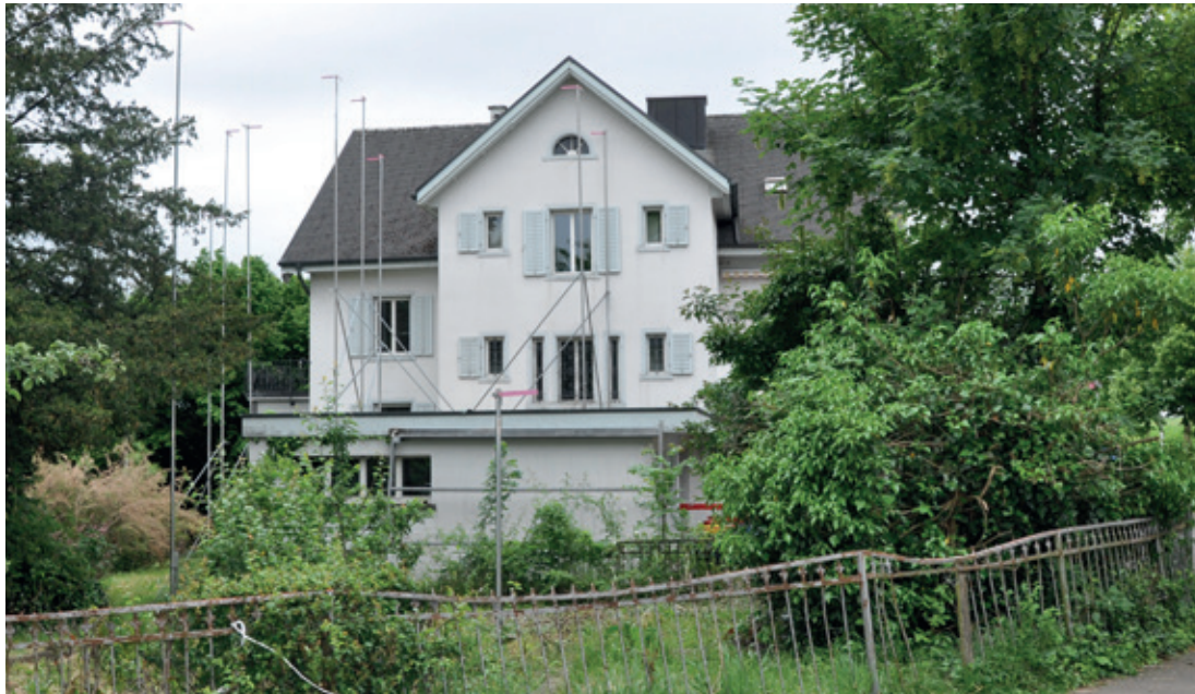
Das Herrschaftshaus am Bodenacker 14 wird saniert, im Garten baut die Eigentümerin ein Dreifamilienhaus.
