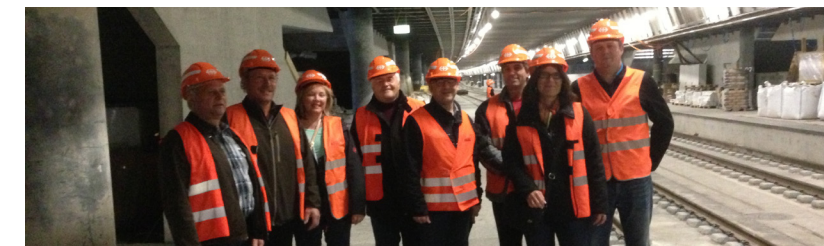
Die SVP zu Besuch auf der Baustelle der Durchmesserlinie.
