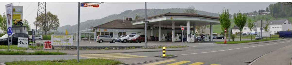
Tankstelle, Shop, Bäckerei und Restaurant – vier Bereiche unter einem Dach: «Wohlen Süd» hat sich fest etabliert im Freiamt.
