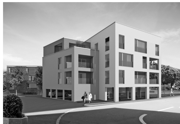
Das Wohn- und Geschäftshaus an der alten Bahnhofstrasse
