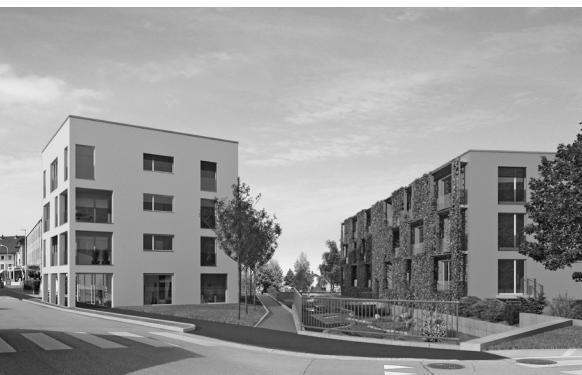
Die beiden Mehrfamilienhäuser mitten im Zentrum
