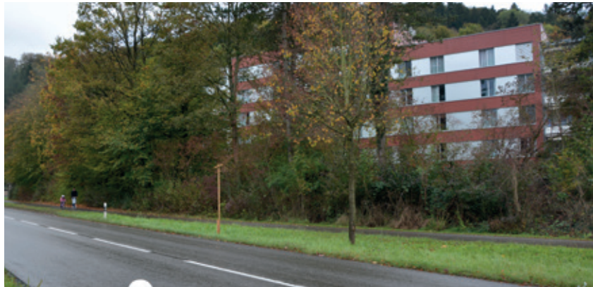
124 Meter soll die Lärmschutzwand vor dem Seniorenzentrum an der Hilfikerstrasse betragen. Für viele ein Unding.
