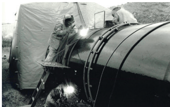
Die zwölf Tonnen schweren Stahlrohre wurden vor Ort verschweisst. Foto: ibw
