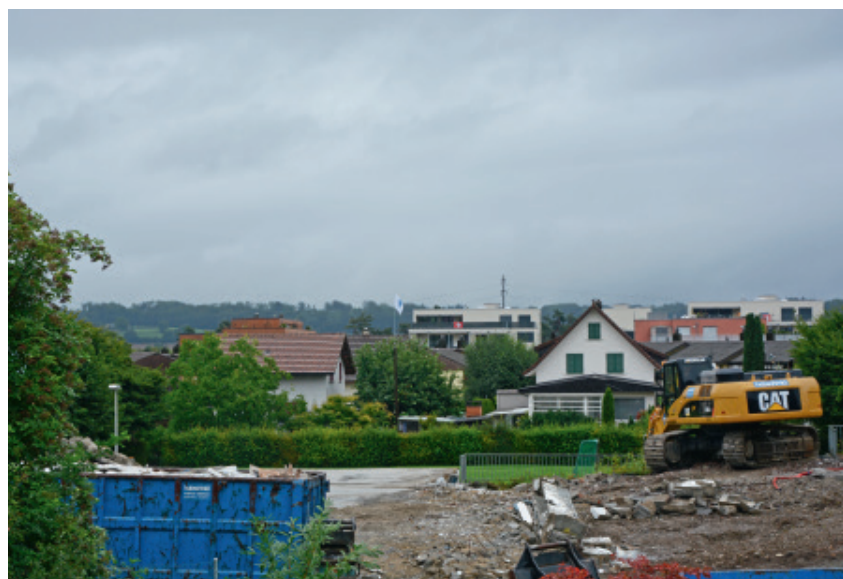
Der Bagger hat volle Arbeit geleistet, der obere Teil ist abgebrochen.
