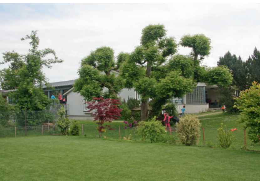
So sah der Kindergarten Bündten vor Baubeginn aus.
