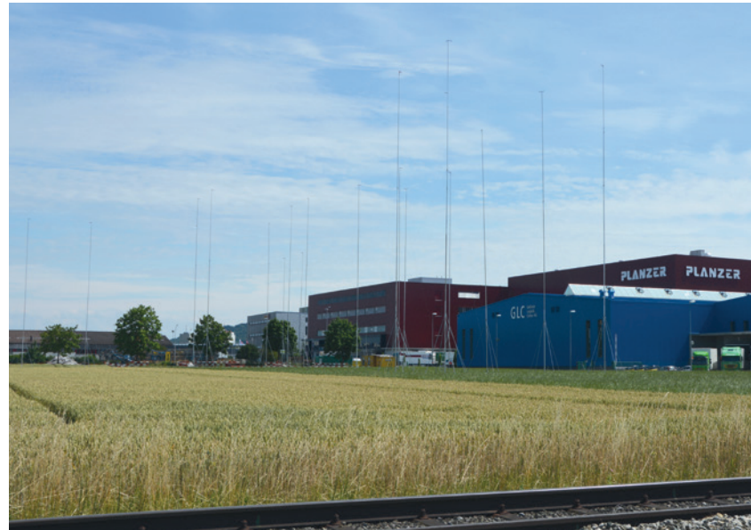
Neben dem bestehenden Gebäude (blau) baut die Gebinde Logistik Center AG ein dreigeschossiges Gewerbehäus.
